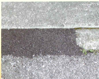
路面の穴の補修
