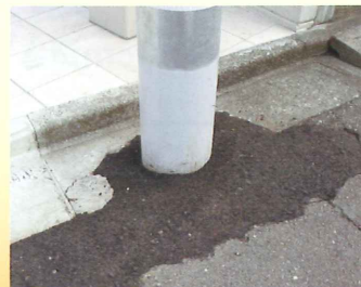
支柱廻りの補修
